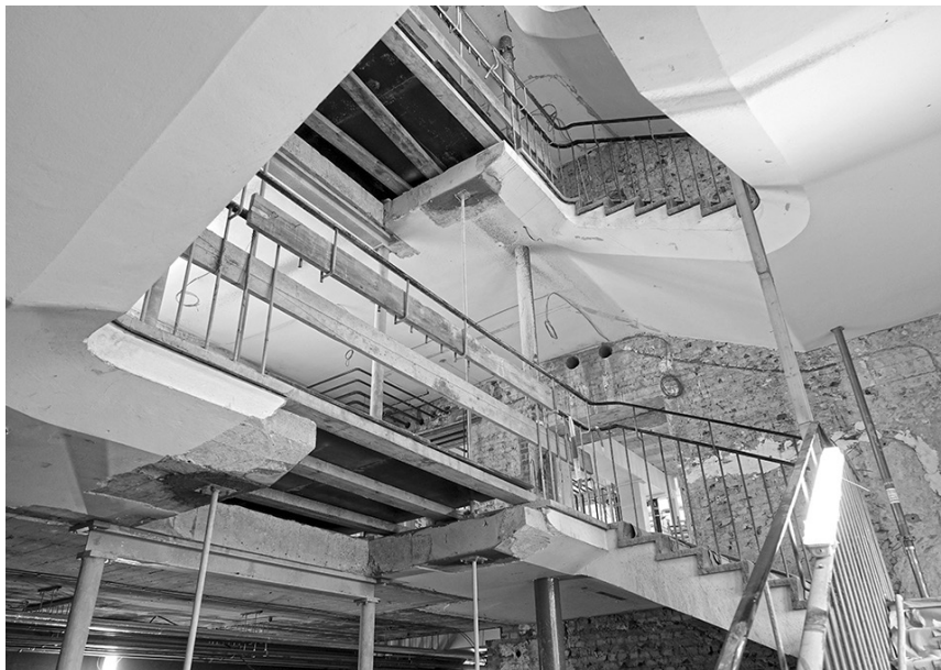
Vorarbeiten für den Aufzug im Haupttreppenhaus
