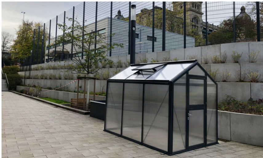
Die Pflanzterrassen und das mit Fördermitteln der Bayer-Schulstiftung finanzierte Gewächshaus
